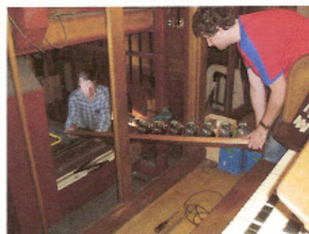
Installation des nouveaux mécanismes de tirage des registres
